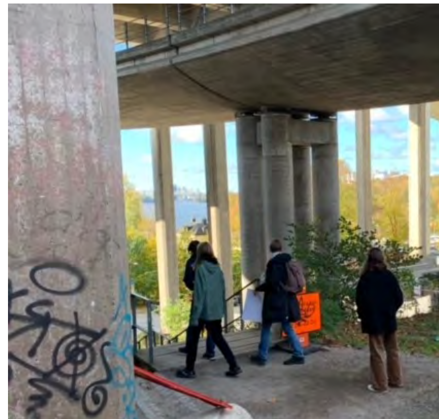
Under Johanneshovsbronns pelare
